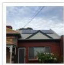
4. Camden Community Centre, SA
